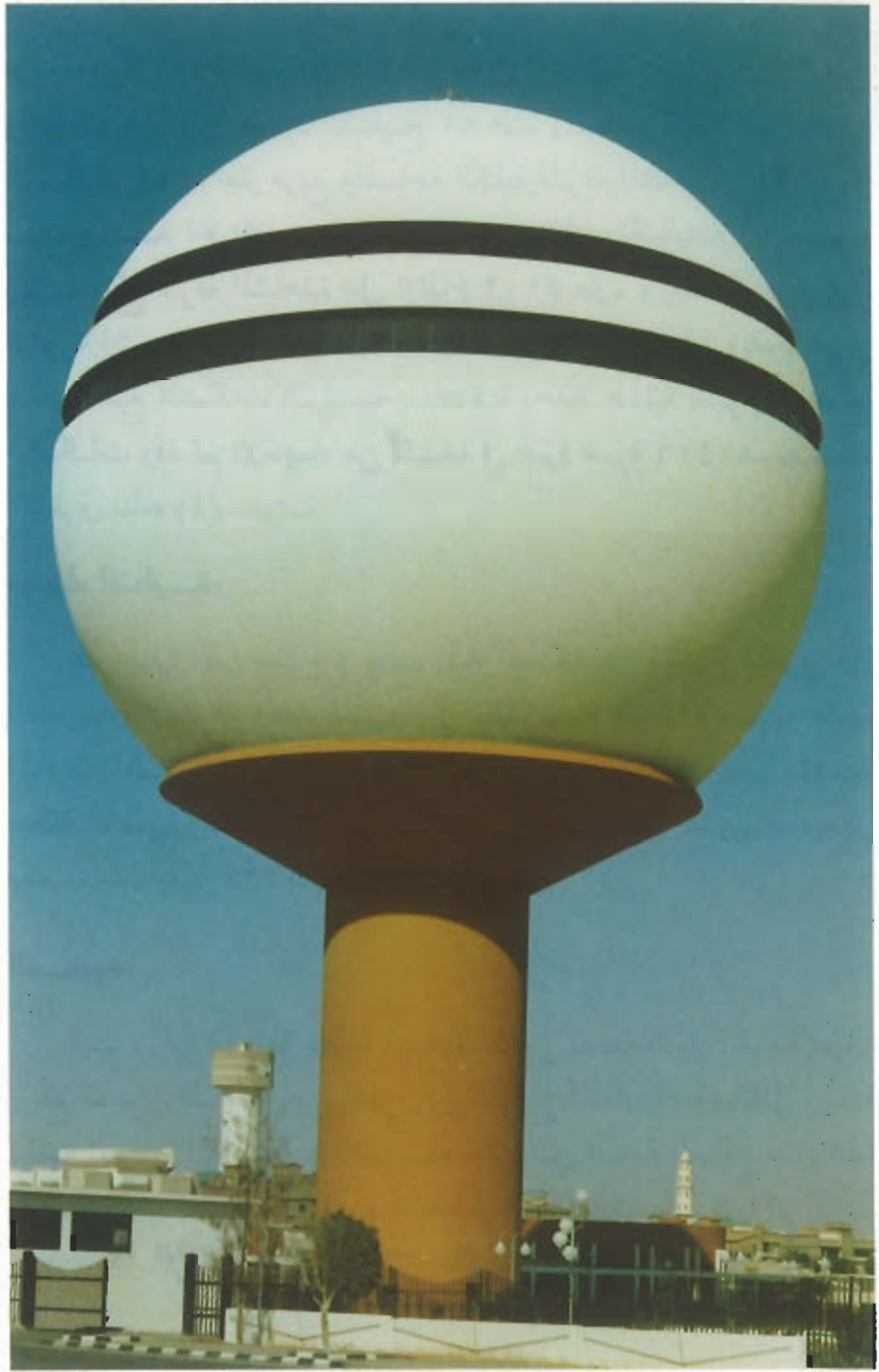
برج مياه بريدة
